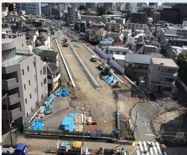
施工状況 (令和3年6月撮影)
