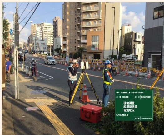
レーザースキャナーによる現道の測定
