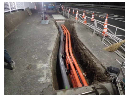
④管路設置
