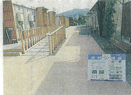
施工前(写真上)と施工後
