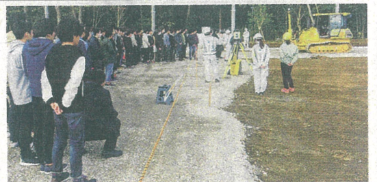
MCによる造成を見学する学生ら
