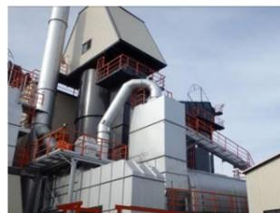
その後、アスファルトプラントに併設されているリサイクルプラントで、再生アスファルト合材として生まれ変わります。
