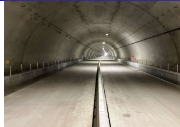
長崎497号 松浦2号トンネル(1工区)舗装工事 〔国土交通省 九州地方整備局 様〕
