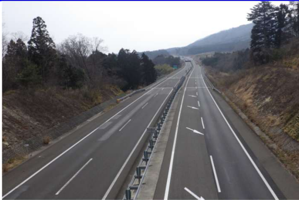
三陸自動車道 R5仙台東管内舗装補修工事 〔東日本高速道路株式会社 東北支社 様〕
