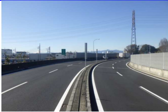
首都圏中央連絡自動車道 所沢管理事務所 管内舗装補修工事 〔東日本高速道路株式会社 関東支社 様〕
