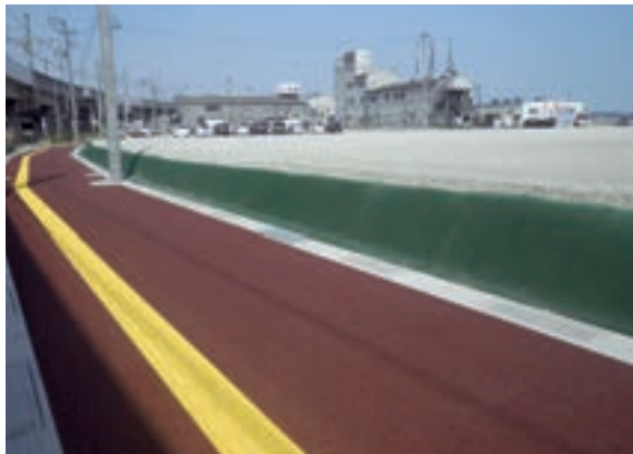
29- 復・交北浜地区復興土地区画整理道路整備工事（その2） （宮城県）
