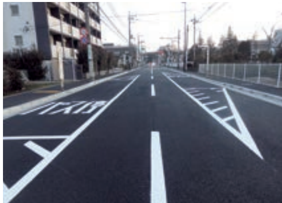
路面補修工事（29 北北の1・歩道改善） （東京都）
