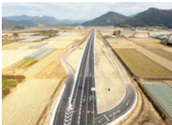
東九州道（清武～日南）松永東弁分地区舗装外工事 （宮崎県）
