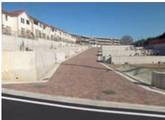
（仮称）横浜市戸塚区前田町計画宅地造成工事 （神奈川県）
