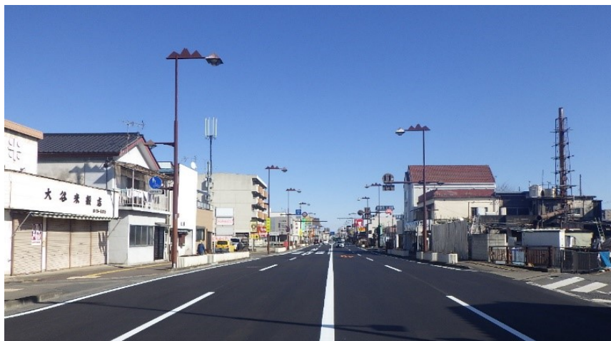
R2国道50号野中舗装修繕他工事（群馬県）
