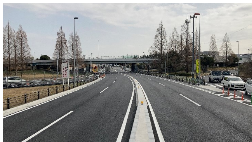
R2大宮出張所管内舗装修繕工事（埼玉県）
