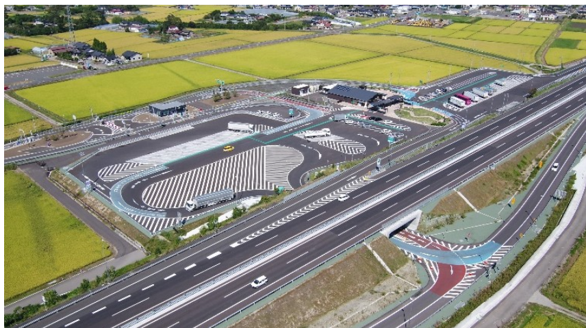
常磐自動車道 山元～岩沼間舗装工事（宮城県）
