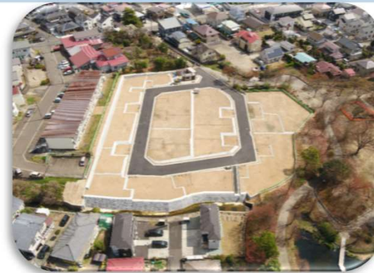
(仮称)仙台市太白区三神峯2丁目計画宅地造成工事 (宮城県)
