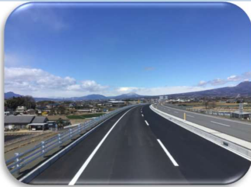
R4国道17号上武道路今井地区舗装その1工事 (群馬県)
