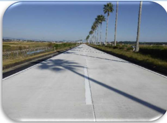
令和4年度郡司分甲地区外舗装修繕工事 (宮崎県)
