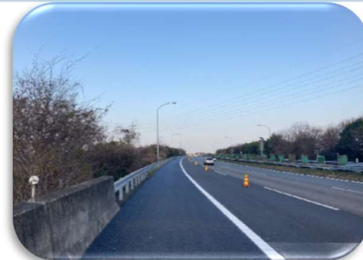
東名高速道路(特定更新等)静岡管内舗装改良工事(2020年度) (静岡県)
