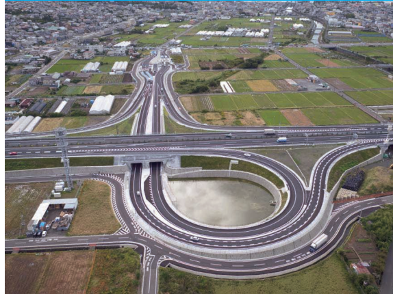
東名高速道路東名静岡東スマートインターチェンジ舗装工事 (静岡県静岡市)
