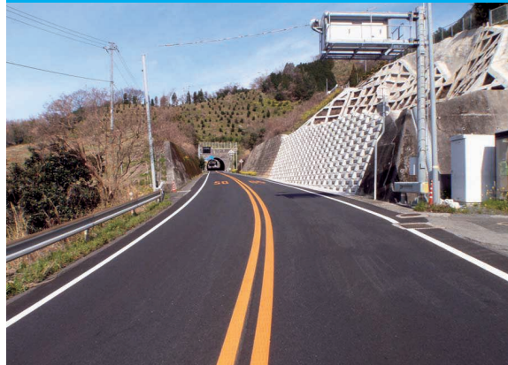
令和元年度吉田舗装修繕(その2)工事 (愛媛県宇和島市)
