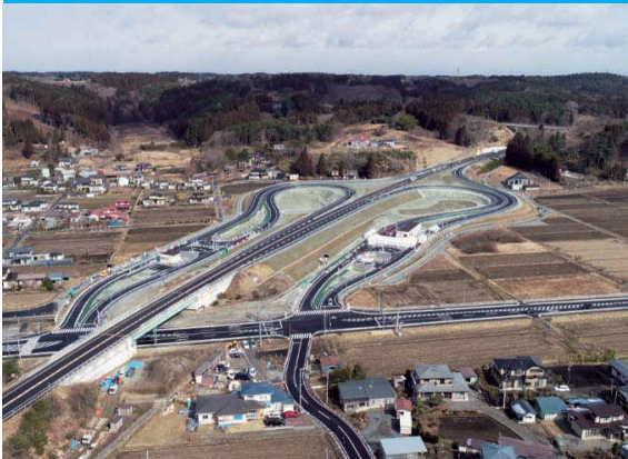
八戸自動車道浄法寺～下田百石間舗装補修工事 (岩手県二戸市～青森県上北郡)
