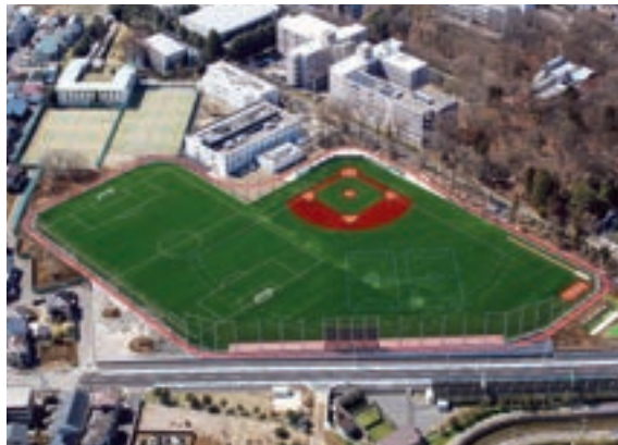
芝浦工業大学大宮キャンパス総合グラウンド整備工事 (埼玉県)
