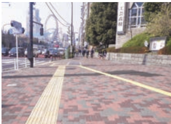
自転車走行空間整備工事 (28-六-2) (東京都)
