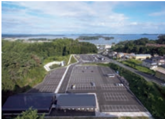
三十刈地区避難場所整備その2工事 (宮城県)
