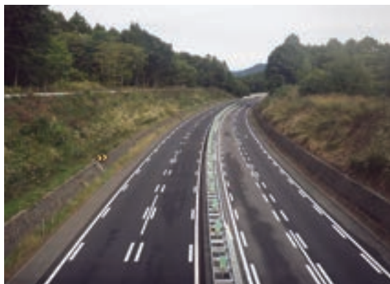
中央自動車道松本管内舗装補修工事 (平成26年度) (長野県)
