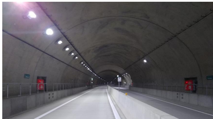
国道106号平津戸トンネル舗装工事（岩手県）
