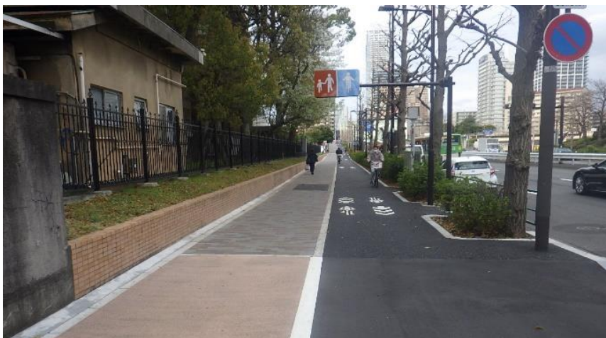
電線共同溝設置に伴う歩道整備工事（東京都）
