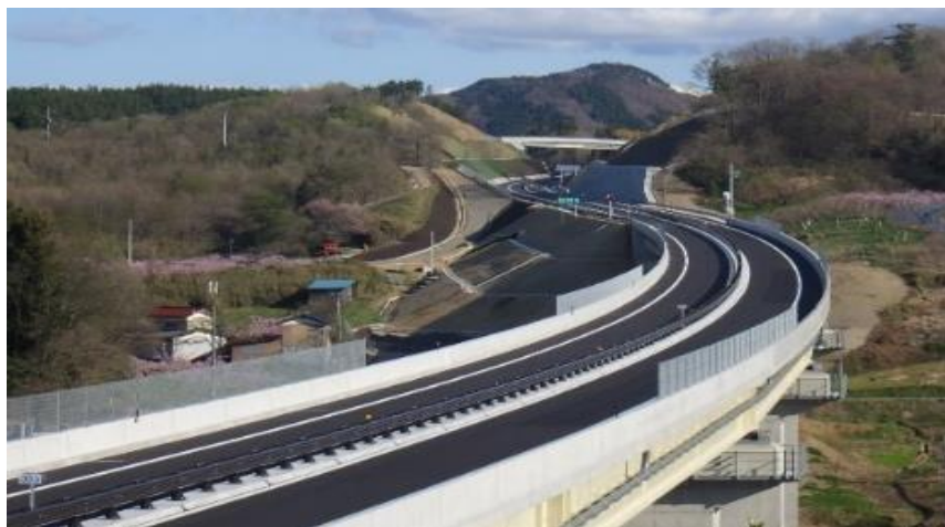
将帰坂地区舗装工事（福島県）
