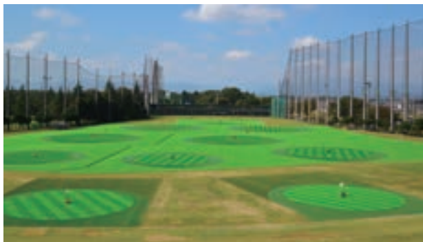
昭和の森ゴルフ練習場改修工事（東京都）
