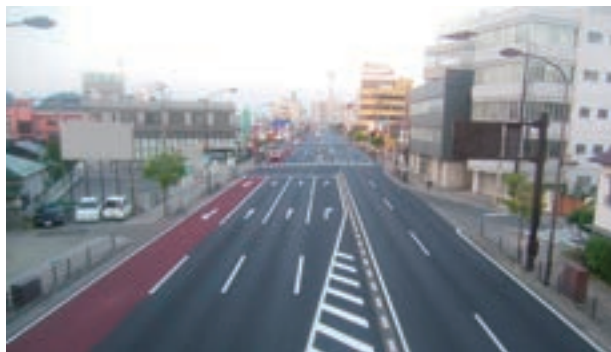
本内地区交通安全対策工事（福島県）
