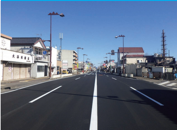
R2国道50号野中舗装修繕他工事 (群馬県)
