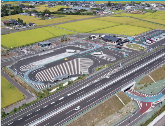
常磐自動車道 山元～岩沼間舗装工事 (宮城県)
