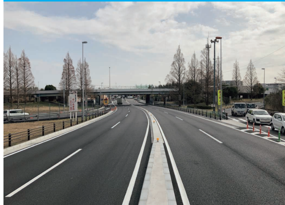
R2大宮出張所管内舗装修繕工事 (埼玉県)
