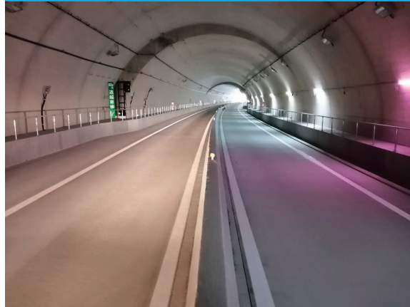
国道45号沢向玉川地区舗装工事 (岩手県)
