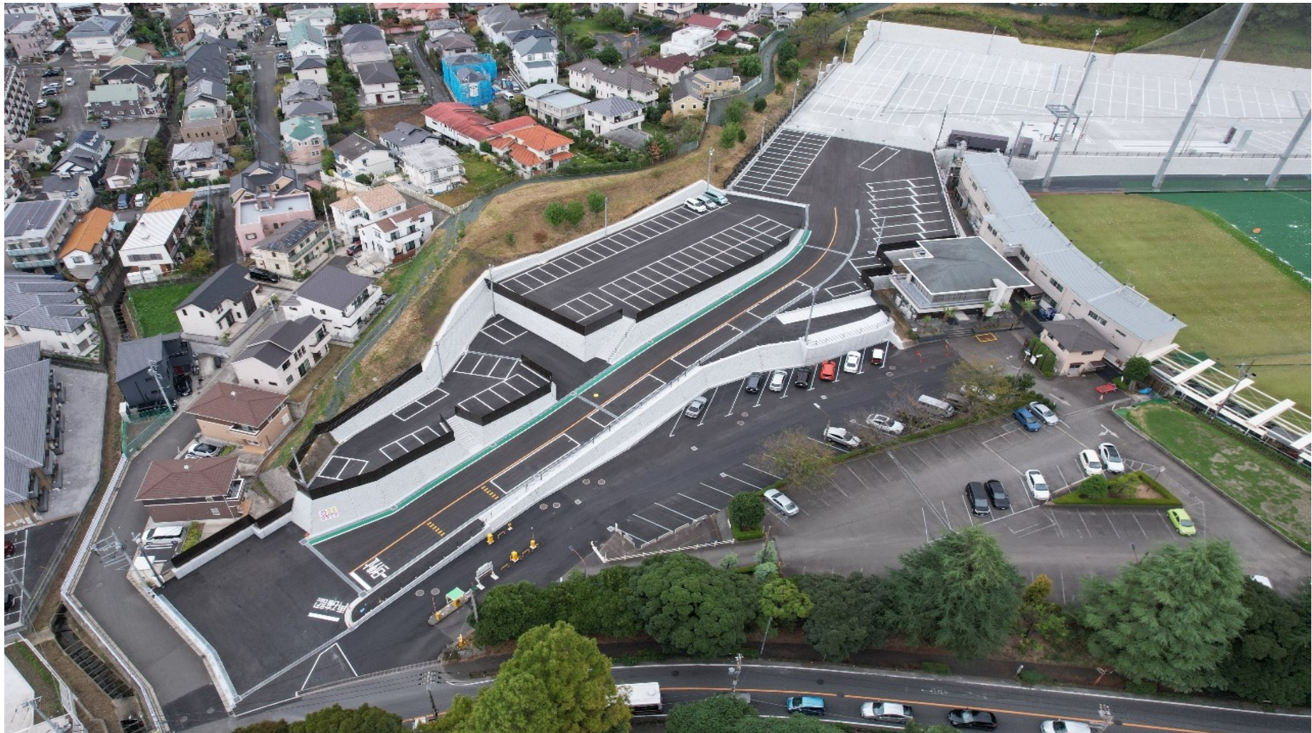
小田急バス新百合ヶ丘営業所車庫造成工事（神奈川県）
