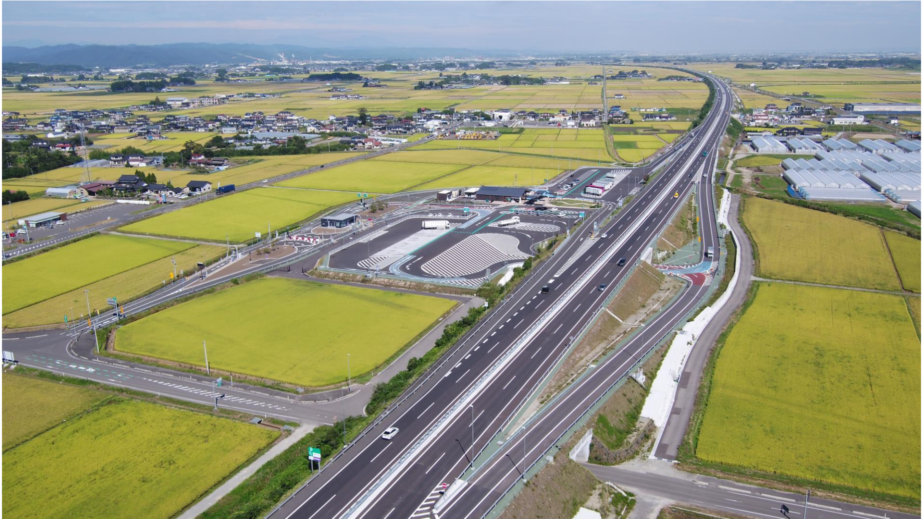
常磐自動車道 山元～岩沼間舗装工事（宮城県）
