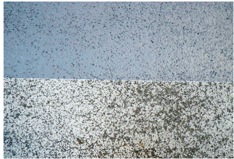
遮熱材を塗布した路面（上）
